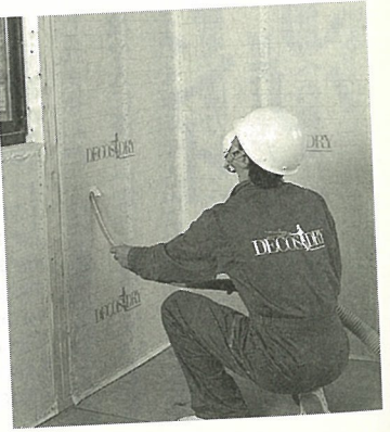
新聞紙をリサイクルしたセルロースファイバー断熱材（CF断熱材）
