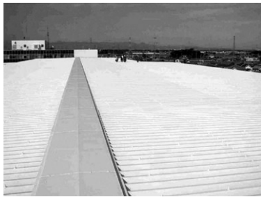
図 4.2.3 高日射反射率塗料を塗装した屋根
