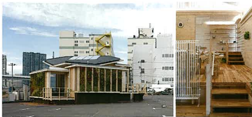
左：慶應義塾大学のエネマネハウス「慶應型共進化住宅」。右：内部はCLTを現して使用しており、個室をつくらず段差によってエリアを分けるワンルーム。
