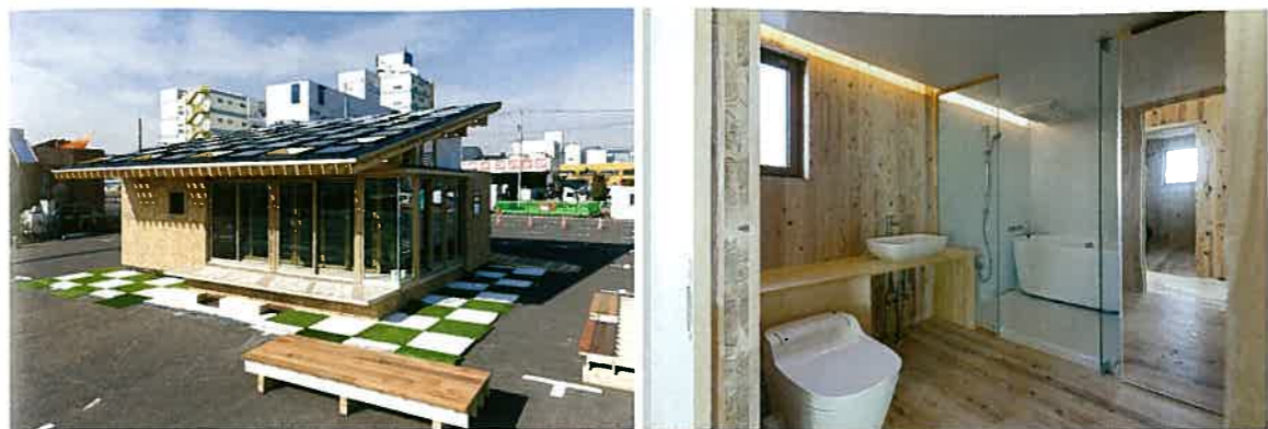
左：来場者の投票により決定するPeople's Choice Awardを受賞した、芝浦工業大学のエネマネハウス「母の家2030—呼吸する屋根・環境シェルターによるシェア型住宅スタイル」。右：内部には、キッチン、寝室、バス・トイレの3つのCLTによる環境シェルターが設置されている。
