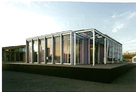
左:早稲田大学のエネマネハウス「Nobi-Nobi House ~ 重ね着するすまい」。右:中心に設備コア、その外側に居住ゾーン、さらに外側をNobi-Nobiゾーンが囲む三層構造。
