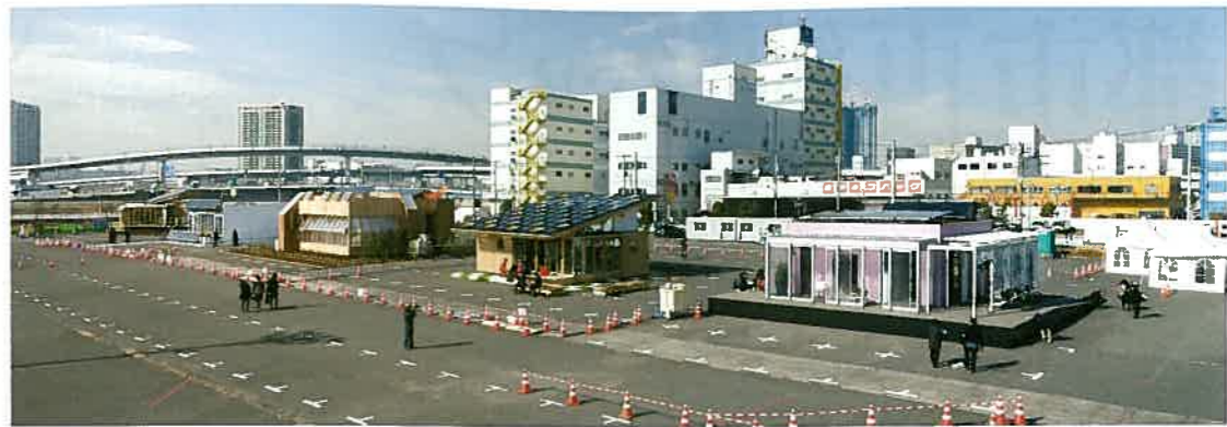
エネマネハウス2014は2014年1月29日～31日までの4日間にわたり、東京ビッグサイト東雲臨時駐車場にて開催された。20m角、隣棟間隔6mの敷地内に5大学が提案するエネマネハウスを建設、効果を実証した。
