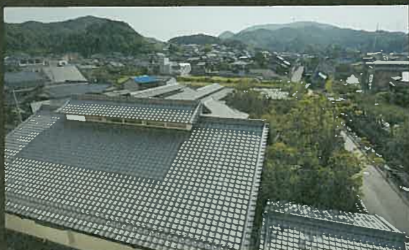
瓦屋根が美しい。左の大きな屋根の建物が多目的ホール。
