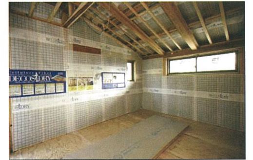
壁と屋根などに入れて完了する。家が完成すると見えなくなる。
