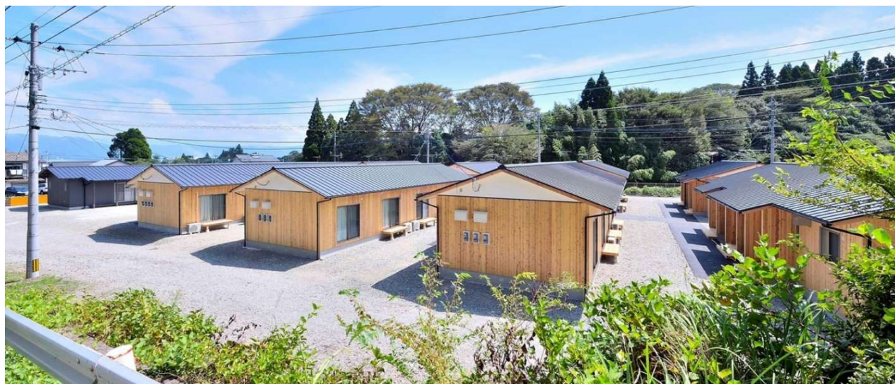
熊本地震木造応急仮設住宅 563 戸においてデコスファイバーが採用された（写真は阿蘇市黒川仮設住宅）
