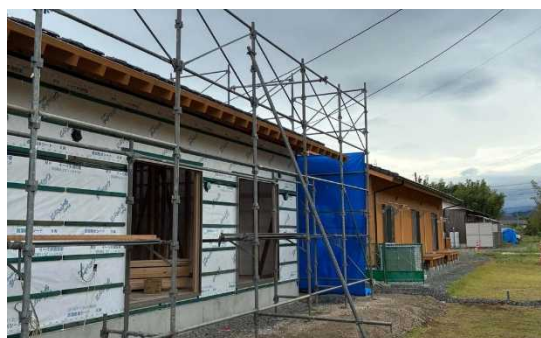
公営住宅に転用された旧仮設住宅（奥）
