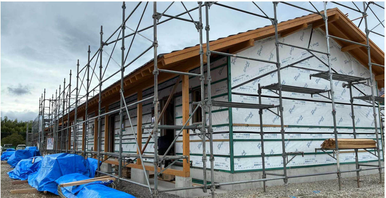
宇城市内の仮設住宅建設におけるデコスファイバーの施工の様子
