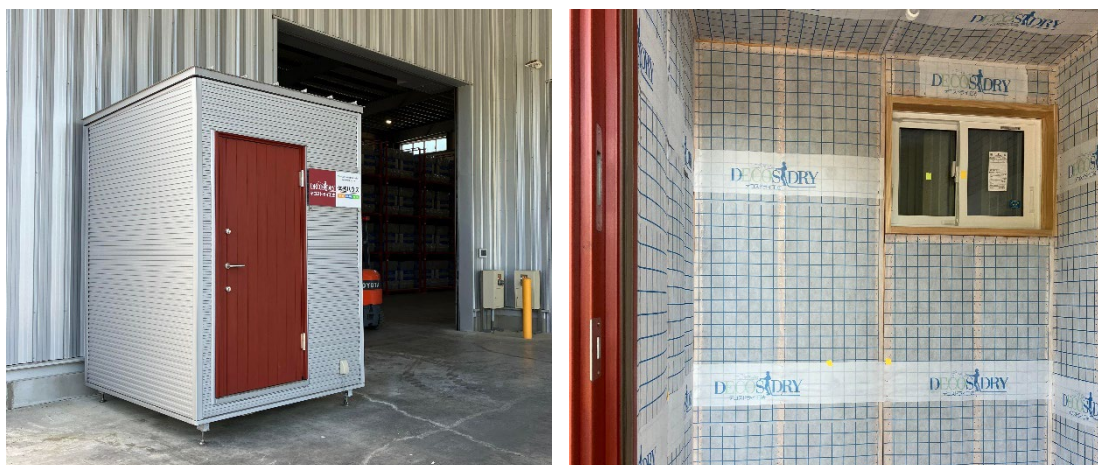
デコスファイバーを施工し、その性能を体感できる温度計・湿度計つき「体感ハウス」
