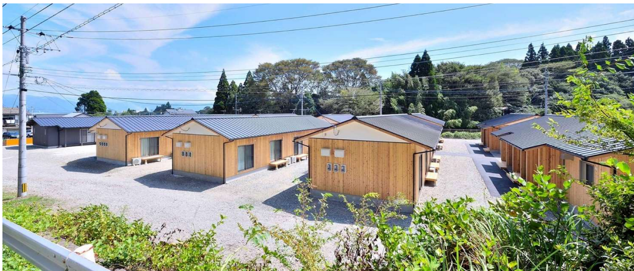
熊本地震木造応急仮設住宅 563戸においてデコスファイバーが採用された（写真は阿蘇市黒川仮設住宅）
