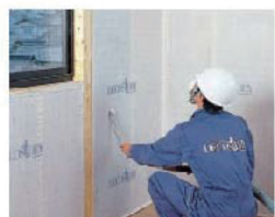
壁断熱(施工密度 55±5 kg/m 3 ) / 柱の厚みいっばいにブローイング。
