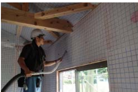
デコスドライ工法の施工風景 透気機能を持つ内装クロスを貼ることで、デコスファイバーの調湿機能を活かした
