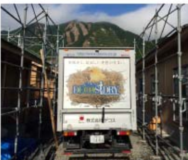
仮設住宅敷地に入るデコスドライ工法の専用施工車
