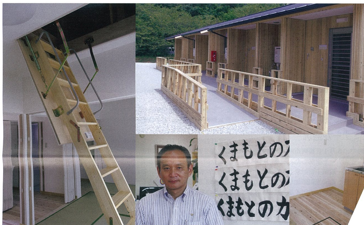
[右上] 無垢板の外壁にセルロースファイバー断熱でU A値0.6を実現 [右下] キッチンが板張りですざわりも柔らかい [下中] 全木協熊本県協会・久原英司会長 [左] 収納力を補うため天井裏収納を設けた
