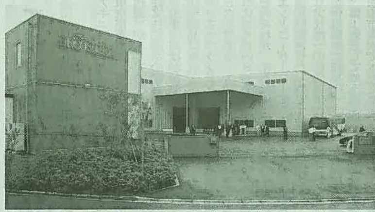
2ヵ所目となるデコス関東工場。工場棟のほかに事務所棟(写真手前)を構える。工場棟内には見学スペースや「デコスドライ工法」の施工研修が行えるスペースを設けた
