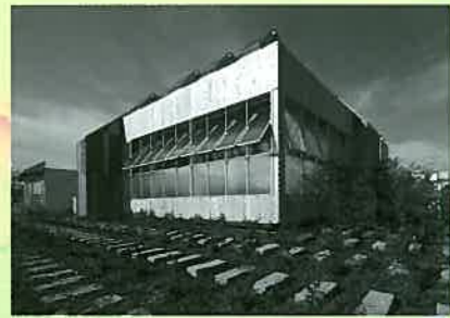
機能をまとめたコンテナ・コアがつくる輸送型エコハウス ルネ・ハウス 震災復興をイメージした自立住宅 千葉大学
