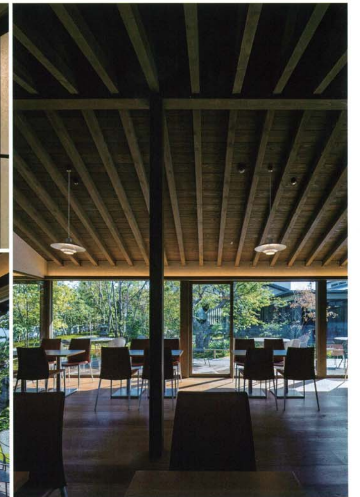
喫茶室。天井はスギ緑甲板貼り。
