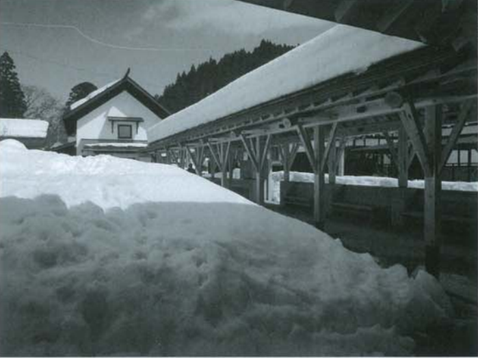
冬場の広場、回廊の様子。
