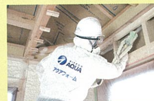
現場吹き付け発泡で 複雑な構造も隙間なく施工
