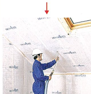
室内側に湿度を通すデコスシートを張りシート内に専用機で吹き込んでいく
