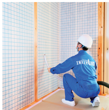
吹込みの様子
