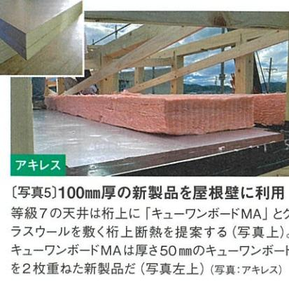
[写真5]100mm厚の新製品を屋根壁に利用
