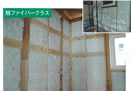
[写真1]最上位製品で厚さを105mmに抑える
