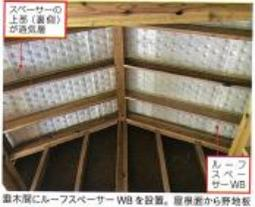
野地板にルーフスベーターWBを設置。屋根裏から野地板を切り抜いて断熱材受け材を取り付けて透湿防水シートを張る
