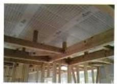
ルーフスベーターWBもしくは透湿防水シートの下部にセルローズファイバーを施工
