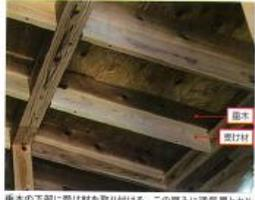
断熱材の下部に受け材を取り付ける。この厚みに透気層とセルローズファイバーを納める
