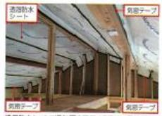
透湿防水シート。野地板から30mm下がったところに空！材を置いて透湿防水シートを張っている。タテローラーを打った部分に気密テープを貼って気密化
