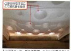
ルーフスベーターWBの仕様。二枚より野地板とスベーターの間に透気層を確保している。
